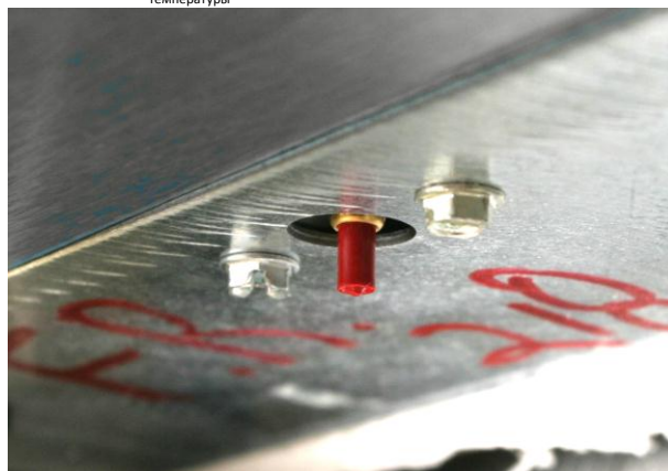
На шкафу фритюрницы под контроллером имеется кнопка возврата к исходным параметрам после отключения устройства из-за превышения верхнего предельного уровня температуры.
